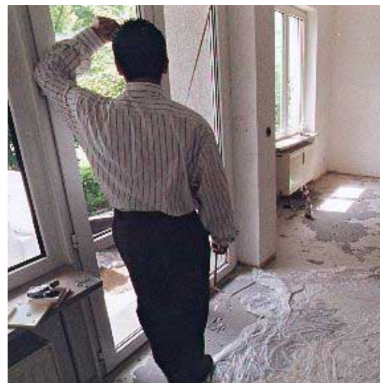
Verlassene Simsek-Wohnung, Einbau einer
