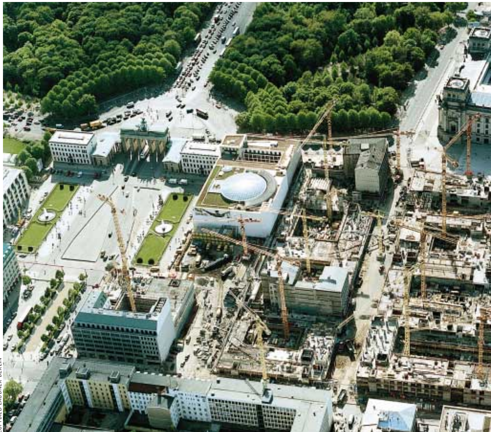
Regierungs- und Bundestagsbaustellen in Berlin: „Vorübergehende Kompetenzlücken“
