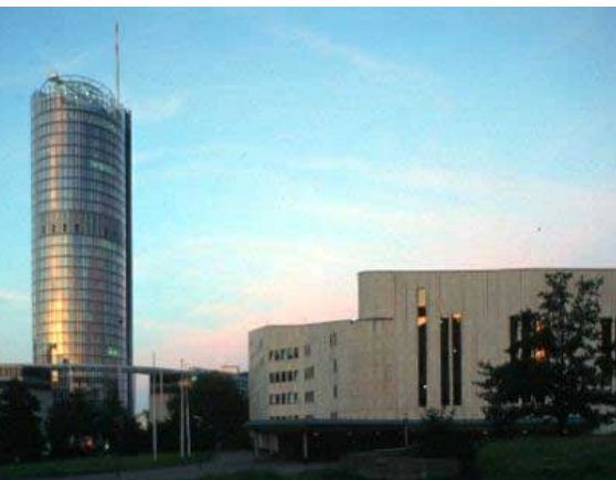
RWE-Zentrale in Essen
